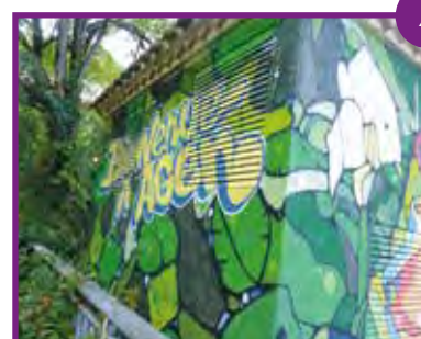
RUE PIERRE PAUL DE RIQUET Mise en peinture de la face manquante du transformateur.
