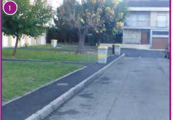
RUES DU MARÉCHAL LANNES ET CHANOINE MARBOUTIN : Réfection des trottoirs et enrobés partiels.
